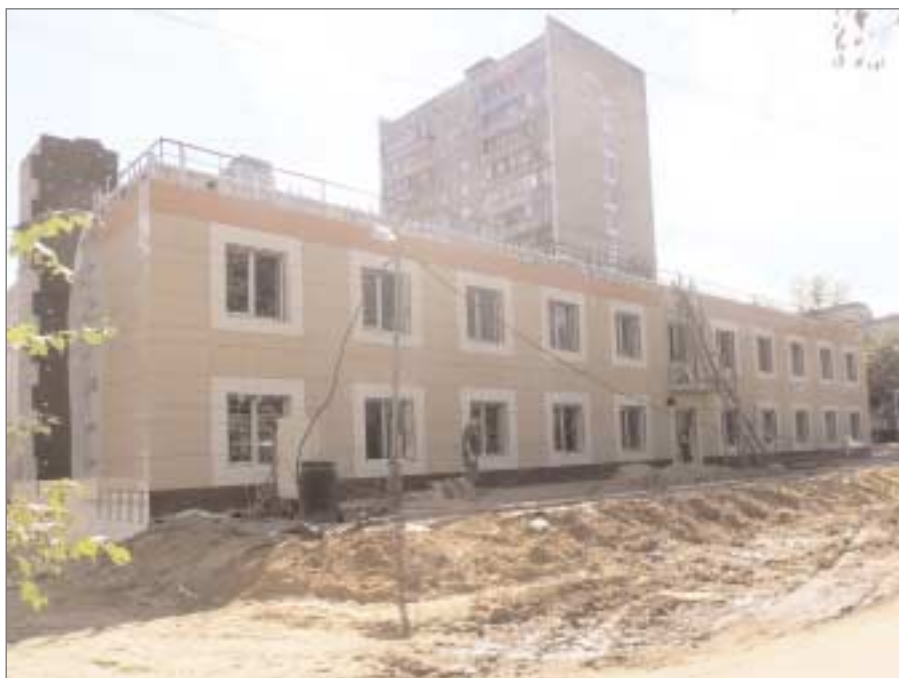
Подземный паркинг по адресу: 15-я Парковая улица, дом 46Б.
