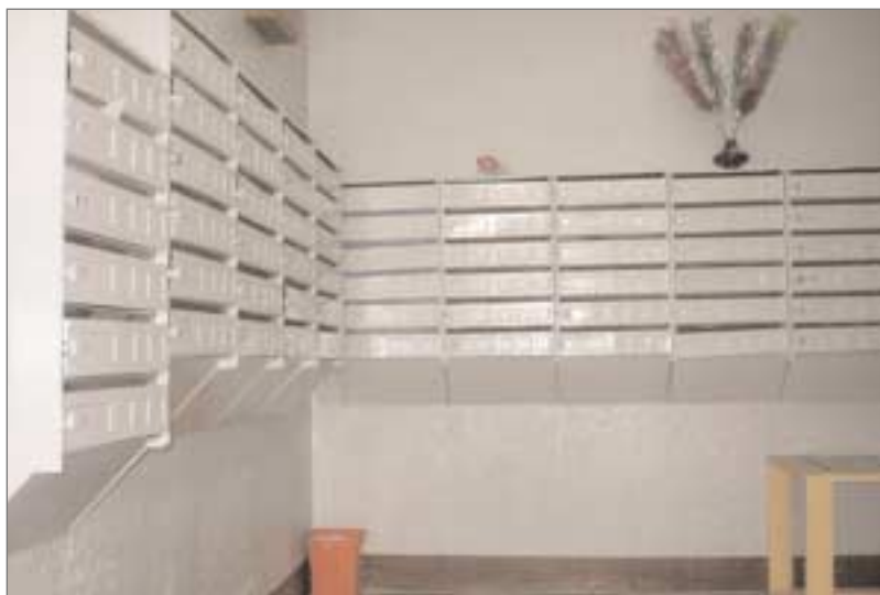
Отремонтированный подъезд дома по адресу: 15-я Парковая, д.38.
