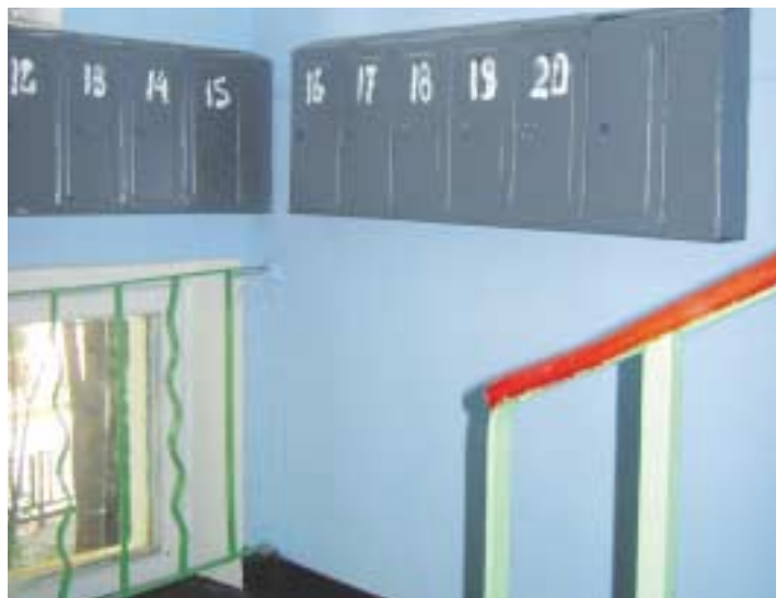
Отремонтированный подъезд дома по адресу: 15-я Парковая, д.46 корп.8.
